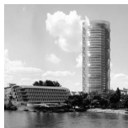
Westhafentower, Frankfurt, Schneider+Schumacher
